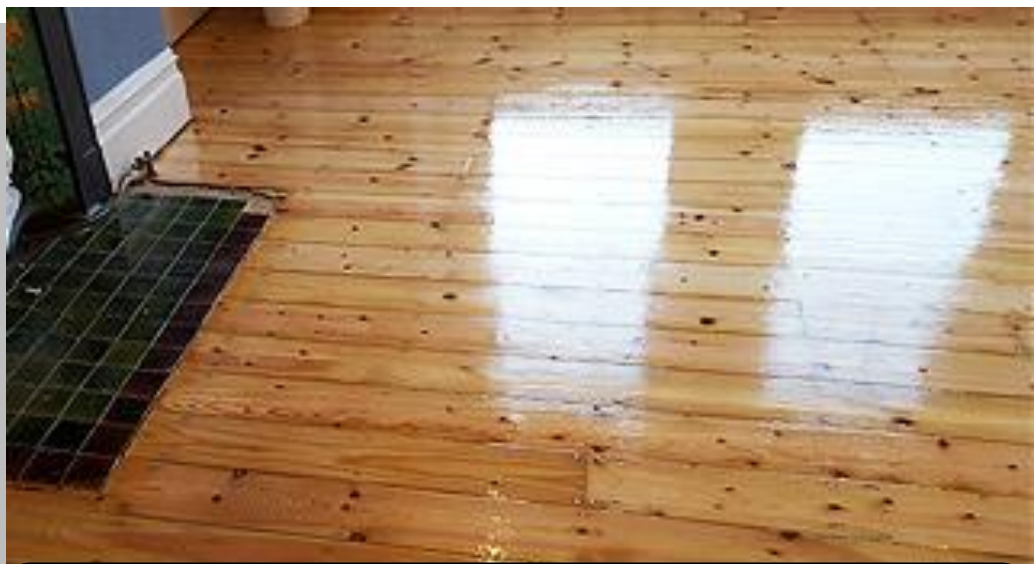
Rajah 1.15 Lantai kayu pine dengan kemasan lekar
