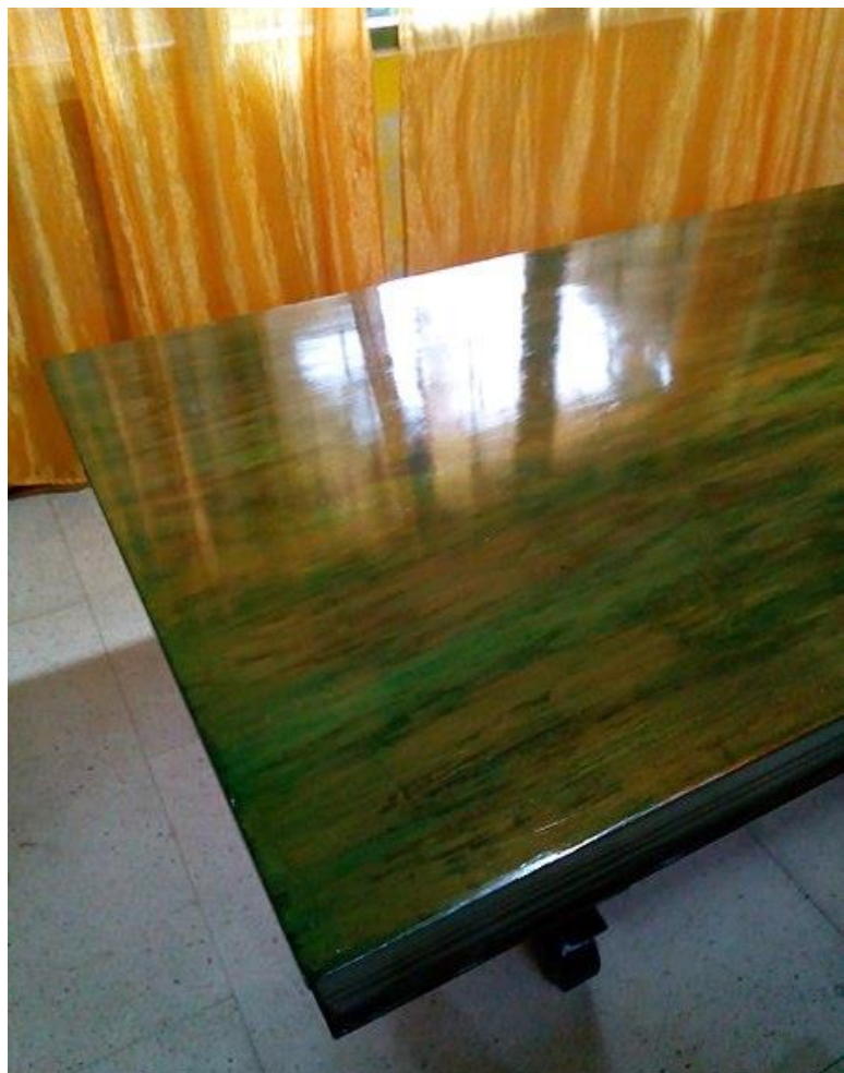
Rajah 1.24 Permukaan meja yang telah disapu dengan tiga lapisan polyurethane varnish
