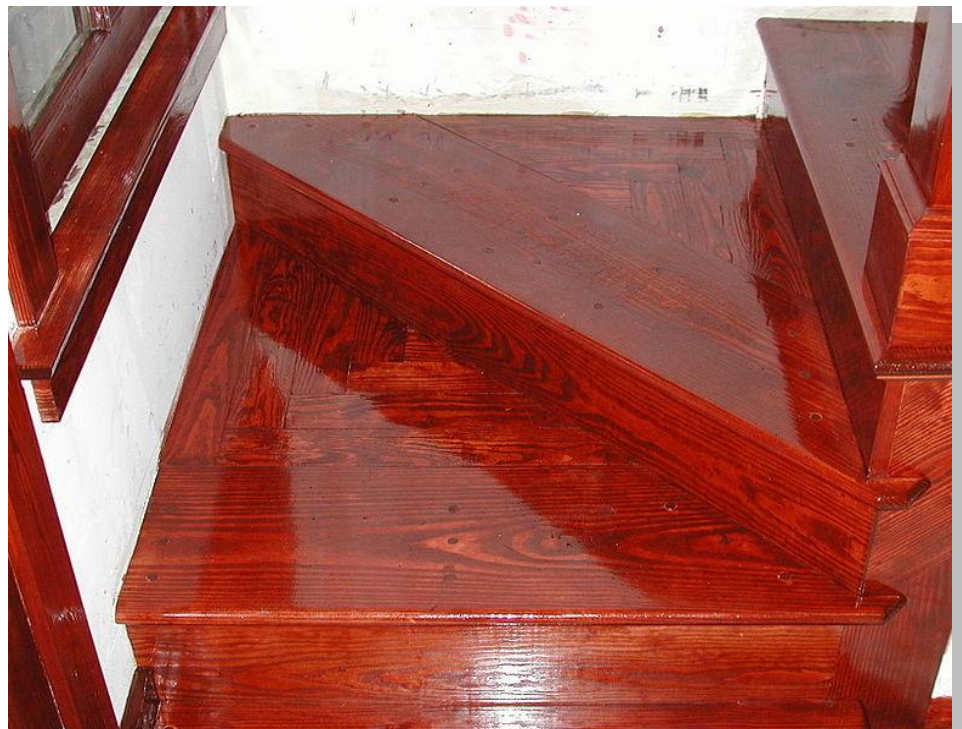
Rajah 1.18 Tangga kayu yang disapu dengan varnish
